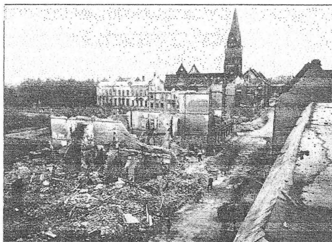
Die zerstörte Inrather Straße Im Hintergrund St. Anna. Foto: Stadtar-
